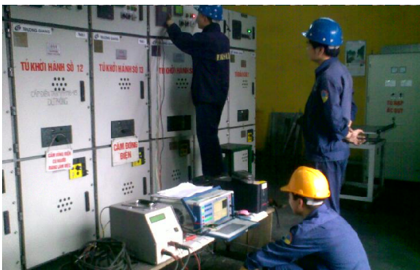
Thí nghiệm hiệu chỉnh thiết bị điện
