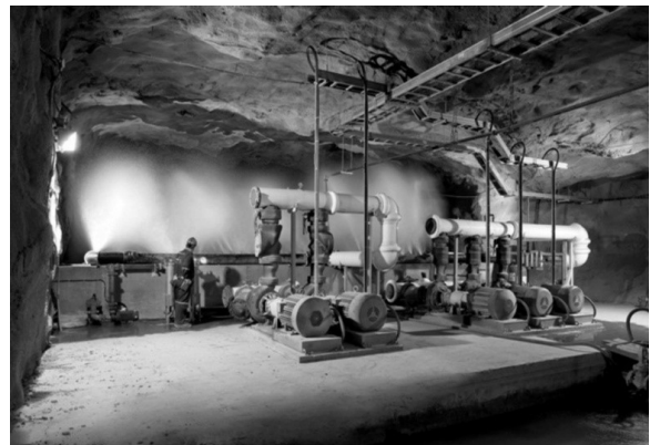
Hình 5. Hệ thống BAC dưới hầm lò tại mỏ Agnico-Eagle (Nam Phi)
