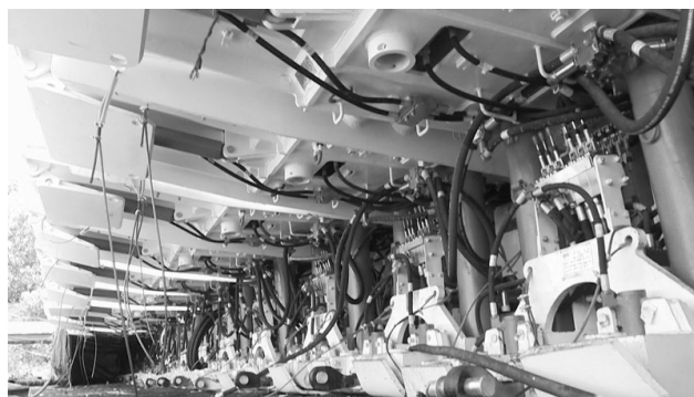
Giàn chống tự hành của dự án Lò chợ cơ giới hóa hạng nhẹ ở Than Mông Dương
