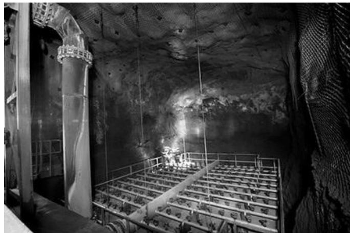
Hình 13. Tháp làm mát dạng buồng ngang được thiết kế đặt trong cúp lò đá
