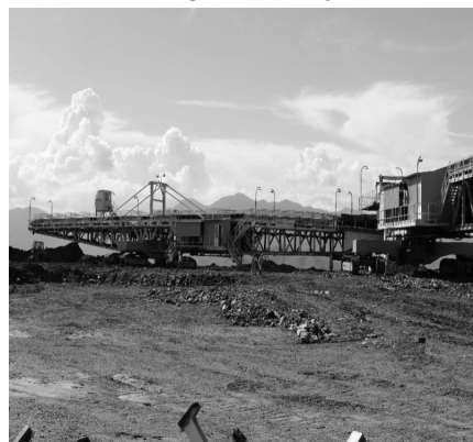
b) Hệ thống dỡ tải
