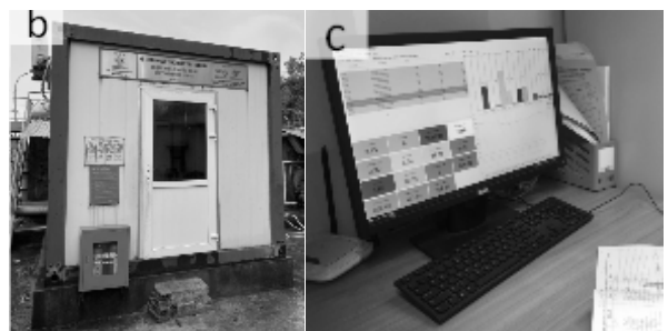
a) Trạm xử lý nước thải lộ thiên 917, Công ty than Hòn Gai; b) Trạm quan trắc tự động liên tục kiểm soát nước thải đặt tại trạm xử lý; c) Số liệu quan trắc được thu thập và truyền về Sở TNMT
