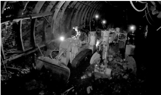
Kết hợp máy xúc gầu ngược và máy xúc lật hông
