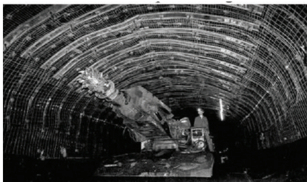
a) Đào thượng khởi điểm bằng máy
