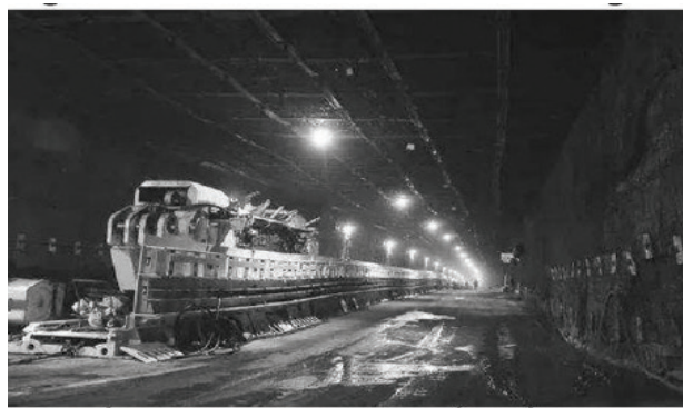
b) Chống giữ thượng khởi điểm bằng vì neo
