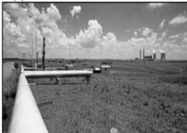
Hình 7. Lắp đặt PWA tại nhà máy điện Majub tại Mpumalanga
