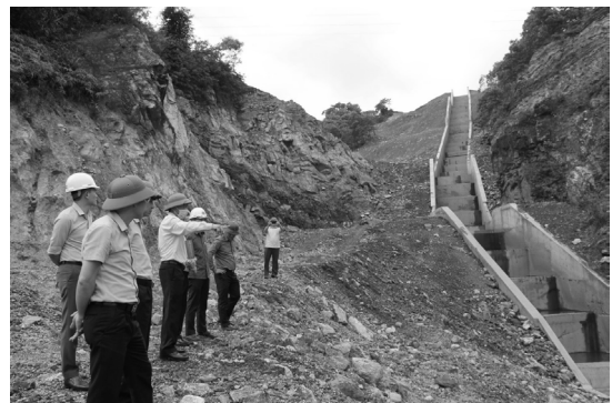
Kiểm tra hệ thống tuyến mương thoát nước Alpha
