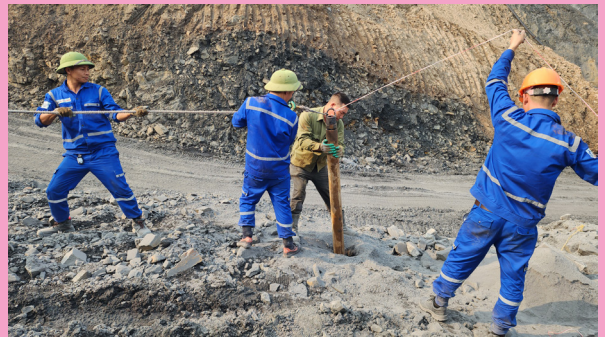
Công tác nạp ống CO 2 lỏng vào lỗ khoan
