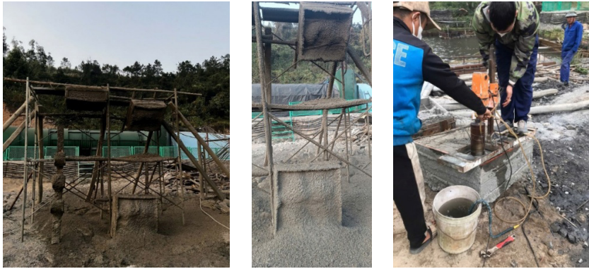
a) Thi công thử nghiệm và khoan lấy mẫu
