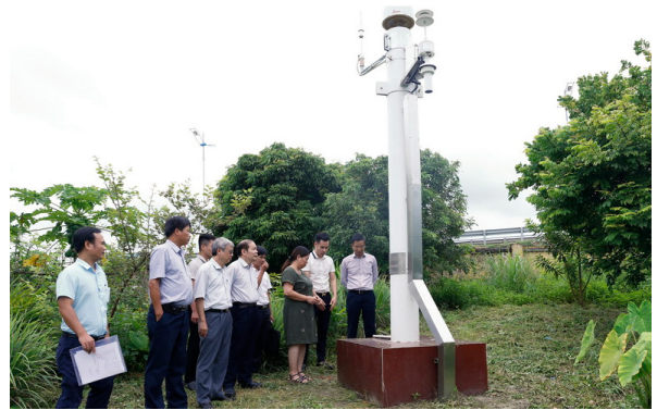
Hình 5. Trạm Cors tại tỉnh Quảng Ninh
